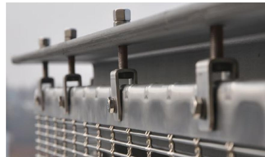
Obere Befestigung: Spannkante und Gabelschraube.
