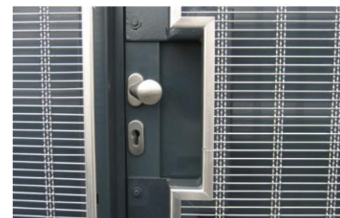
Gewebe-Einfassung mit Kantenschutzprofilen.
