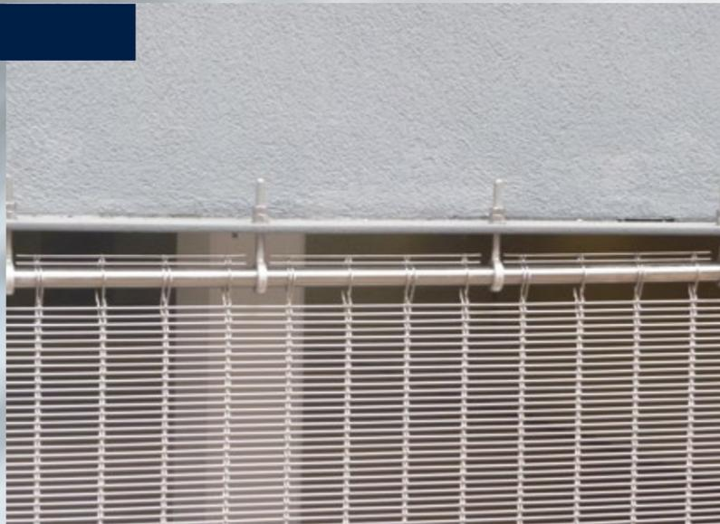
Obere Befestigung: Rundstab mit Augenschrauben.
