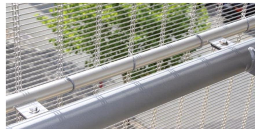
Zwischenbefestigung: Rundrohr und Drahtsicherung.
