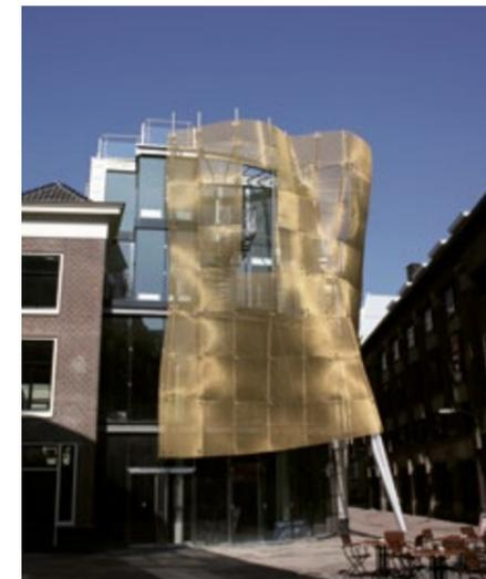
Frei geformtes Edeltstahlgewebe. De Baljurk, Den Haag, Niederlande, DOKA-MONO 1771.
