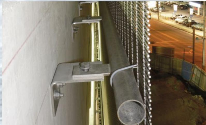
Zwischenbefestigung: Rundrohr und Drahtsicherung.
