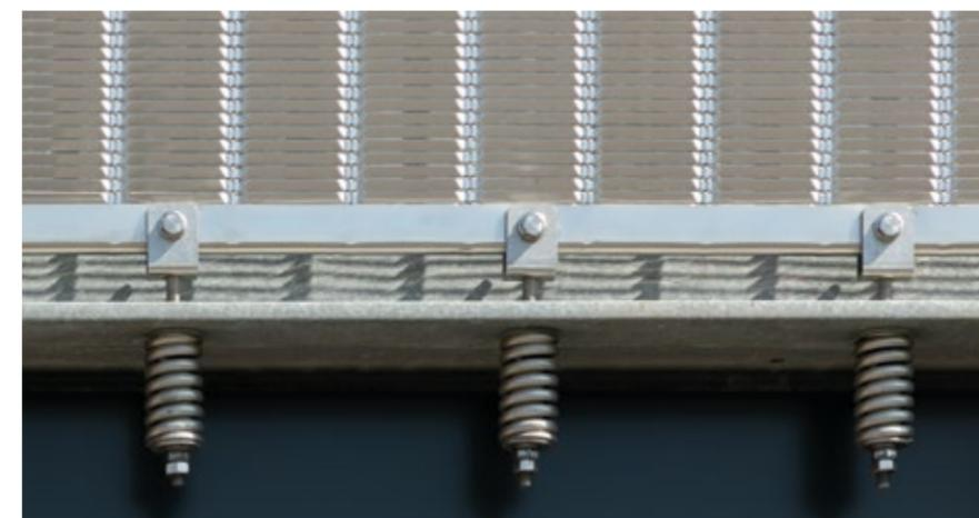
Untere Befestigung: Spannkante, Gabelschraube und Druckfeder.
